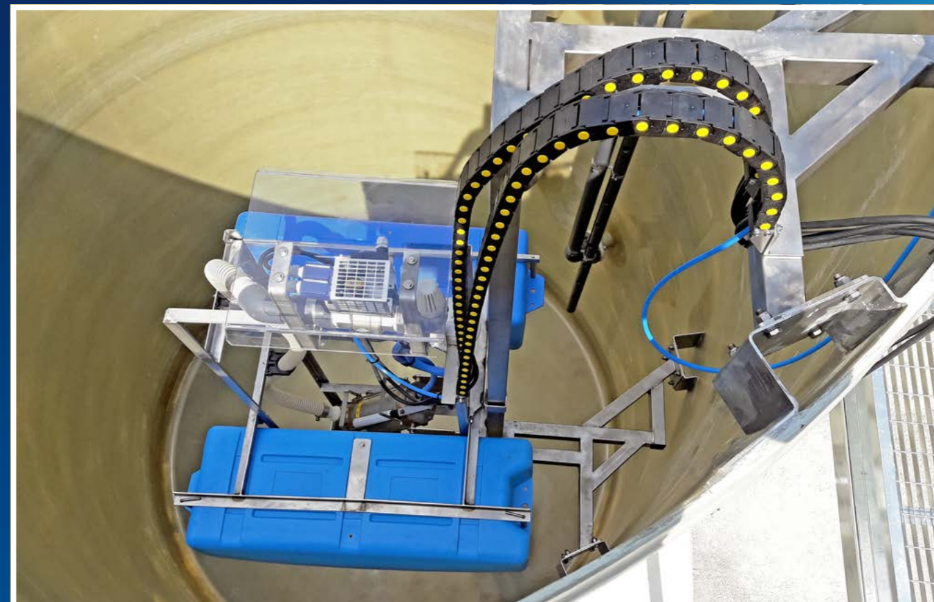
FOTO / DETTAGLIO DELL'AERATORE STORMIX® MODELLO DOTATO DI BOE PER IL GALLEGGIAMENTO ED INSTALLATO SU GUIDE DI SCORRIMENTO SENZA LA NECESSITÀ DI ABBASSARE IL LIVELLO IDRICO IN VASCA.
