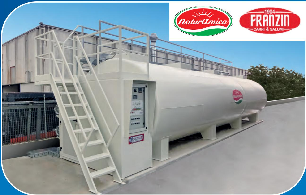
Bioreattore **ECOBLOCK®** diametro mt. 2.5 x 10 di lunghezza.
