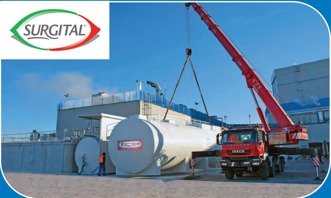
Impianto di depurazione funzionante a innovativa tecnologia MBR attrezzato con n. 2 bioreattori serie ECOBLOCK per alloggiamento membrane.
