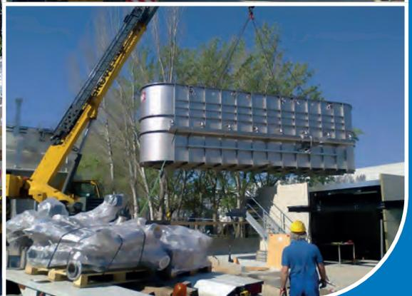
Implementazione SEZIONE MBR, con membrane di ultrafiltrazione a fibra cava, su impianto biologico tradizionale.
