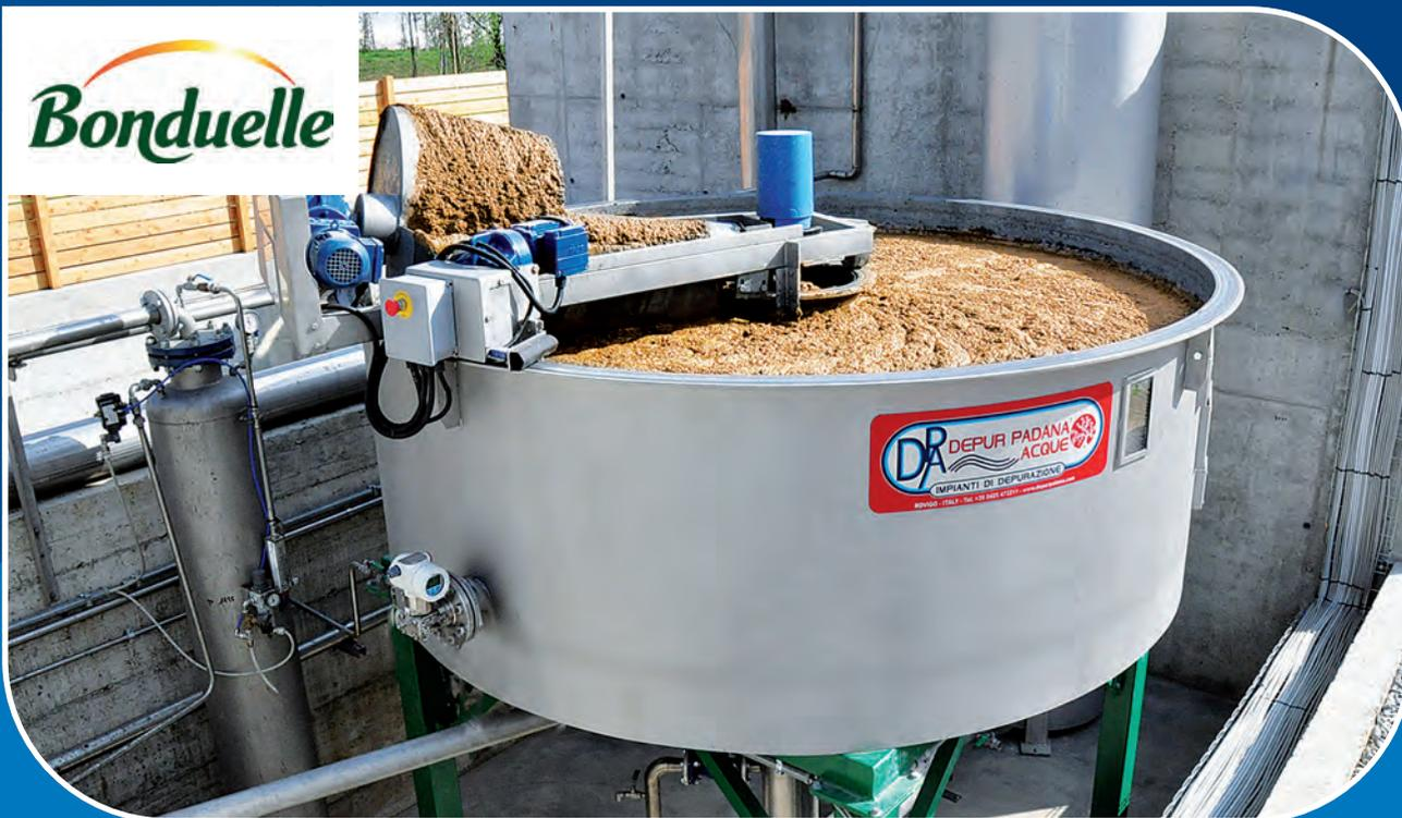
Flottatore di pretrattamento acque derivanti da produzione ortofrutticola, installato a monte impianto biologico MBBR. Potenzialità idraulica 44 m<sup>3</sup>/h.
