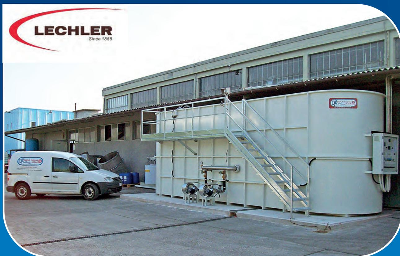
Impianto biologico a funzionamento discontinuo automatico con tecnologia SBR (Sequency Batch Reactor) potenzialità di trattamento: fino a 15 m<sup>3</sup>/giorno.
