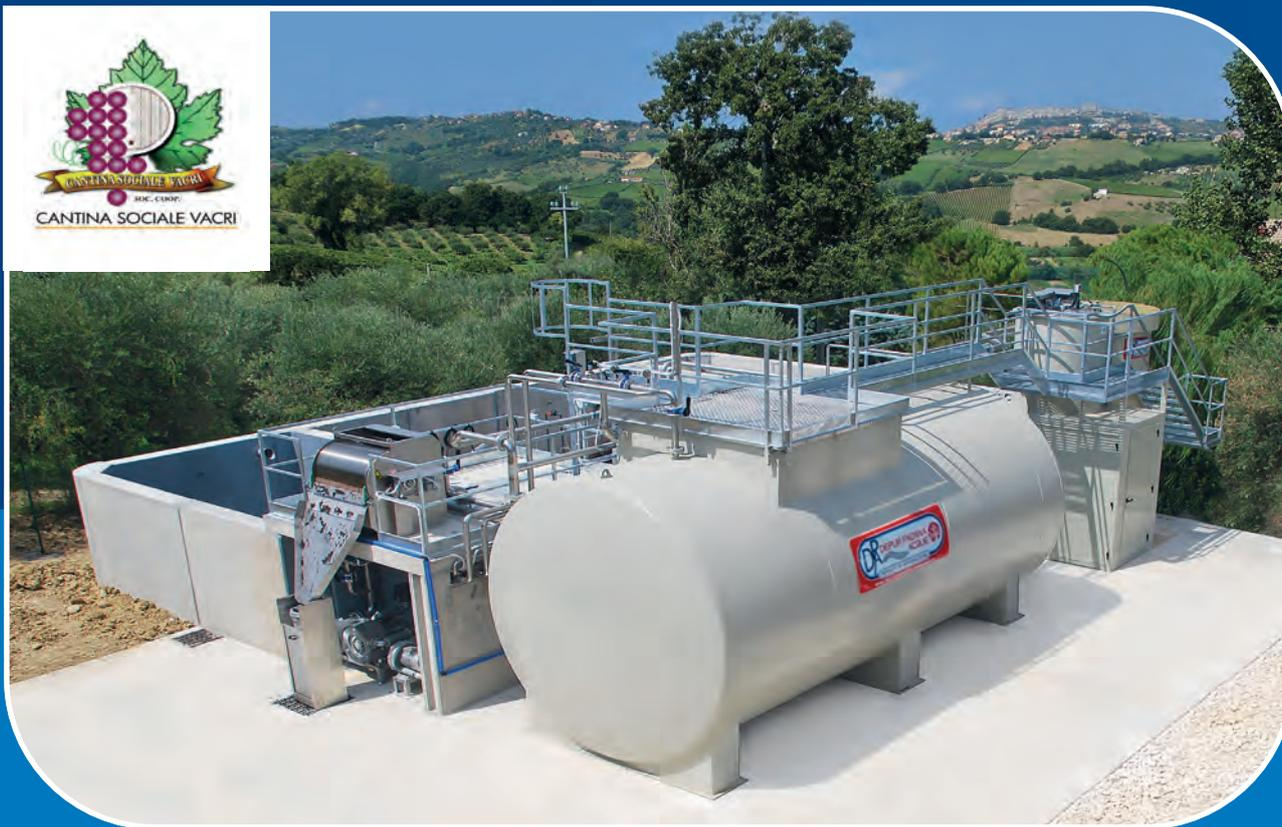
Impianto biologico funzionante a innovativa tecnologia MBR, completo di sezione per abbattimento metalli rame e zinco, idoneo per lo scarico in acque superficiali (e sul suolo).
