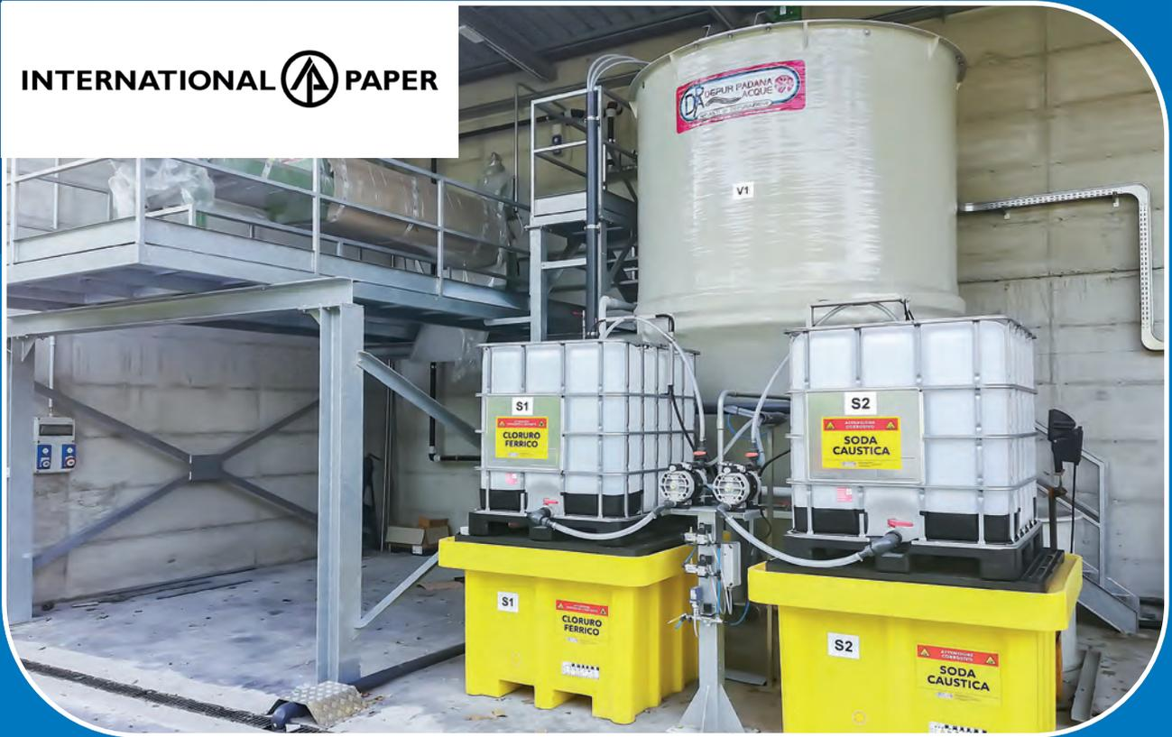
Impianto trattamento scarichi da lavaggio ondulatore e linee stampa flexografica.
