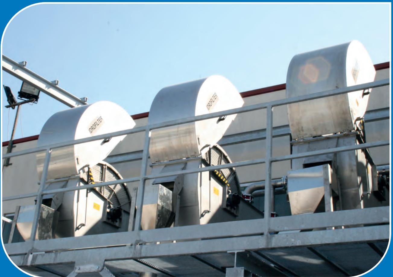
**GRIGLIE DI FILTRAZIONE A DISCHI ROTANTI**
