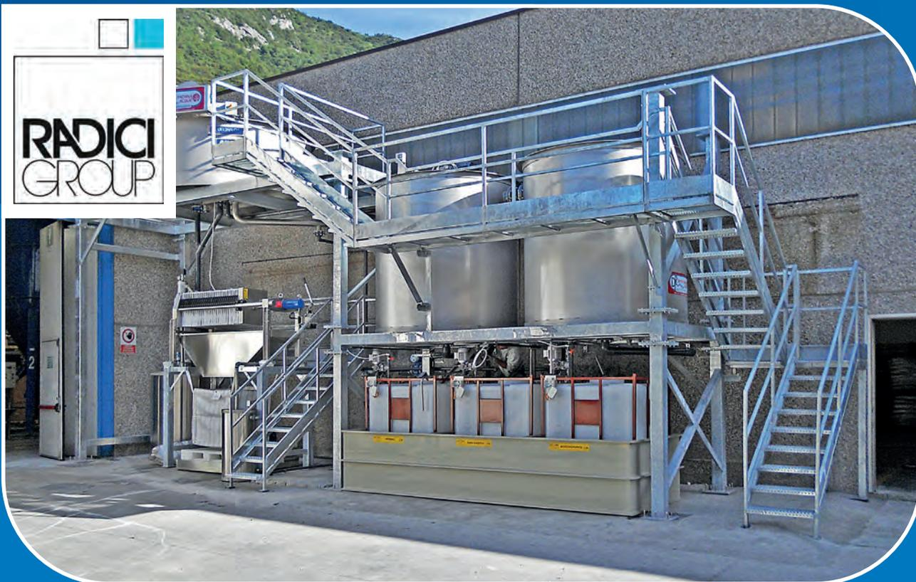
Impianto di trattamento acque di degasaggio a ciclo chiuso mediante flottazione, a servizio di n° 9 linee di estrusione poliammide.
