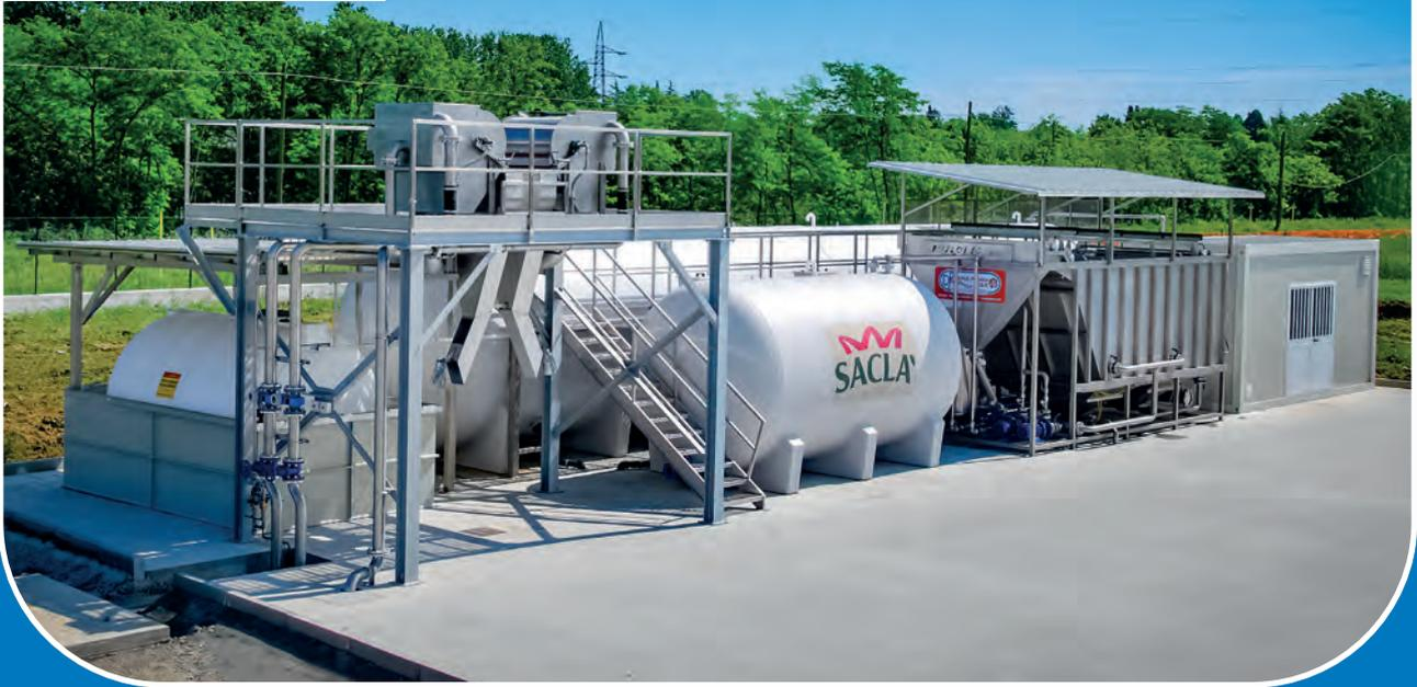
Impianto di pretrattamento acque reflue mediante flottazione ad aria disciolta pressurizzata. Potenzialità max 720 m<sup>3</sup>/g.
