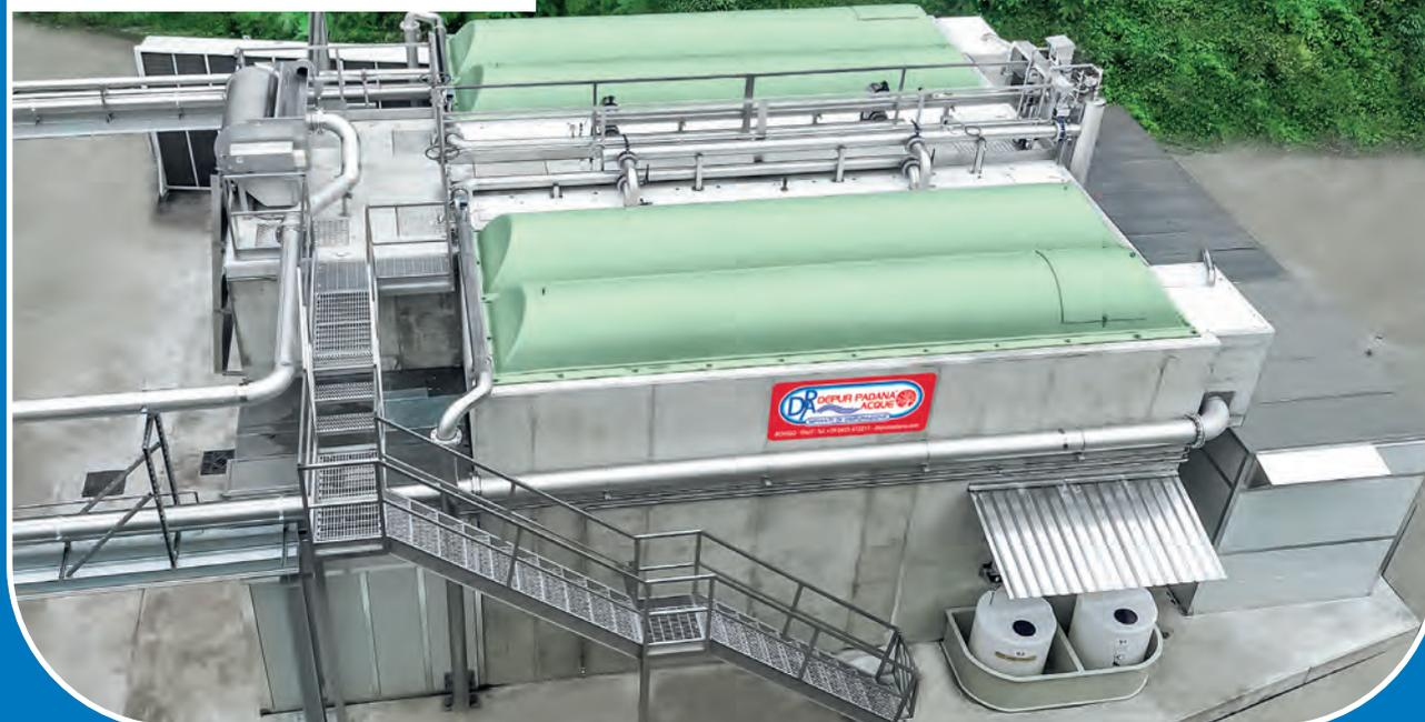
Nuovo impianto di trattamento acque reflue industriali, con applicazione di tecnologia MBR, finalizzato al riutilizzo delle acque in produzione. Potenzialità impianto fino a 2000 m<sup>3</sup>/g.
