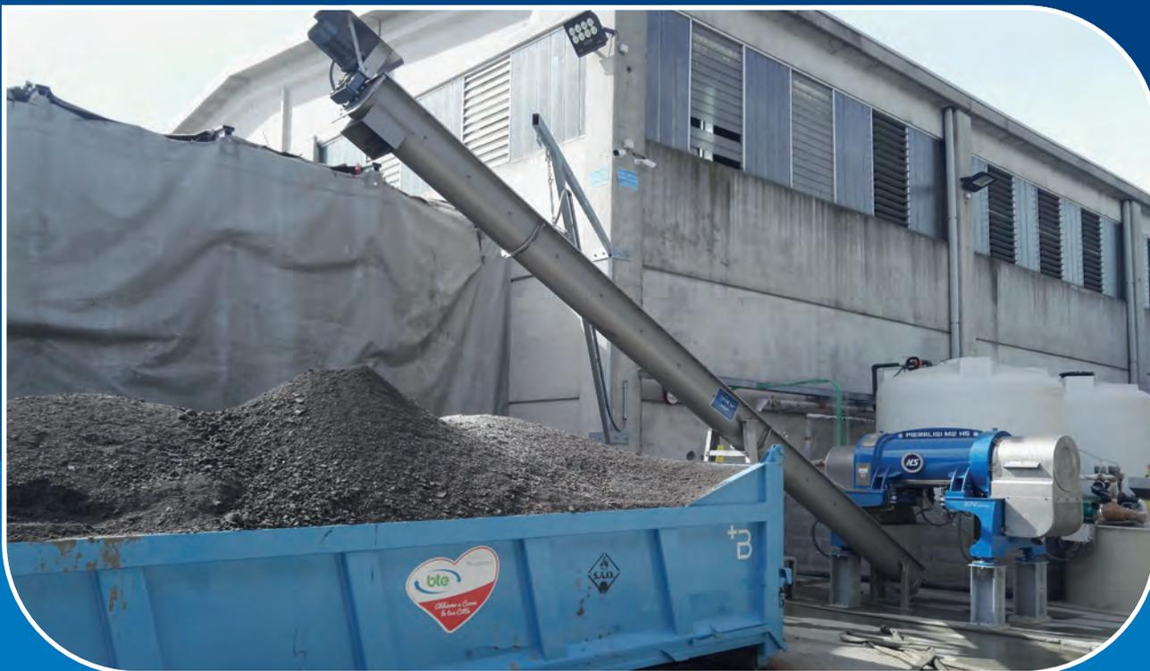
**UNITÀ DI DISIDRATAZIONE MEDIANTE ESTRATTORE CENTRIFUGO (DECANTER) CON COCLEA CONVOGLIATRICE E SCARICO IN CONTAINER**
