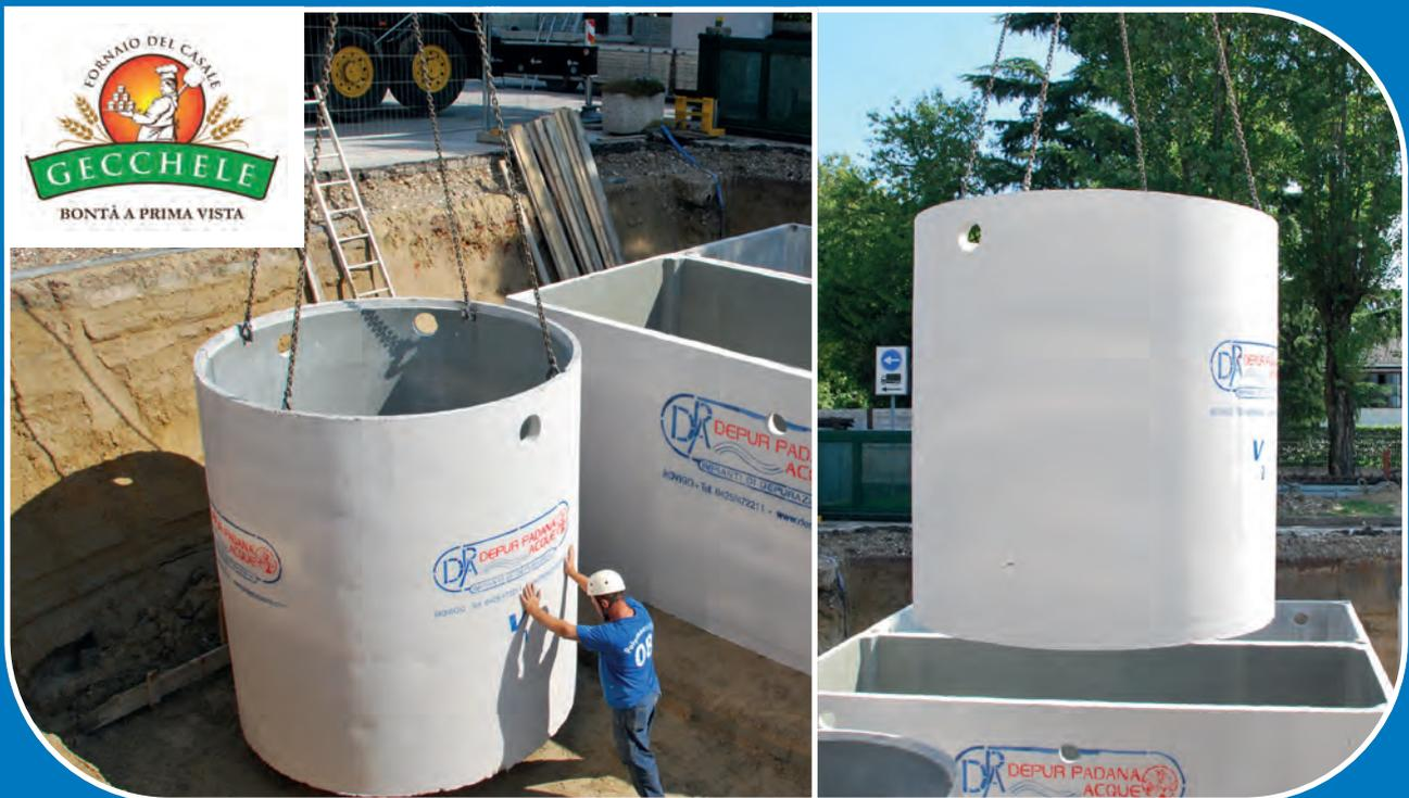
Fasi di scarico e posizionamento vasche di prima pioggia monolitiche, in cemento armato prefabbricato.
