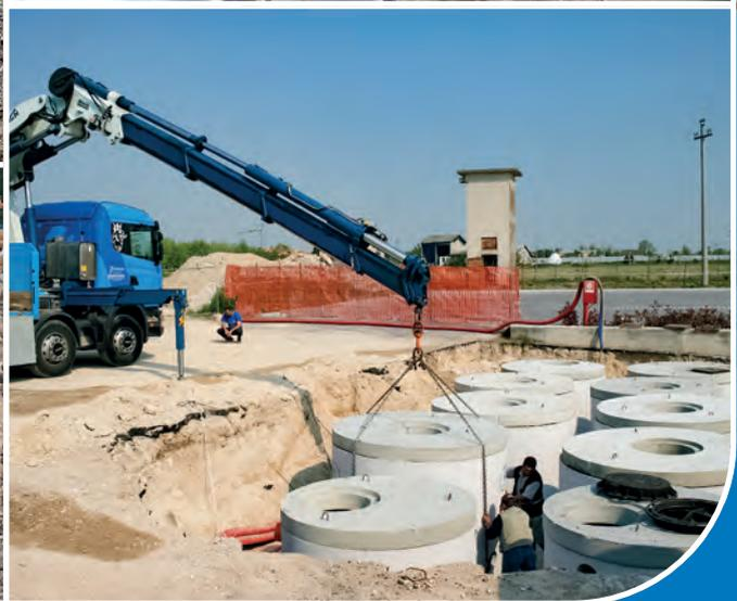
Fasi di scarico e posizionamento vasche di prima pioggia monolitiche, in cemento armato prefabbricato.
