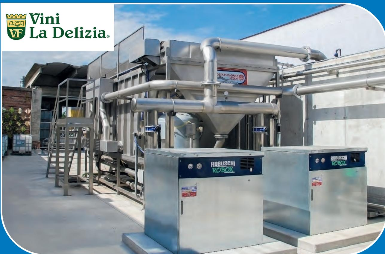
Impianto biologico abbinato a unità di flottazione a pianta rettangolare, ad aria disciolta pressurizzata, progettato per alta e bassa stagione. Potenzialità di 100 m<sup>3</sup>/h.
