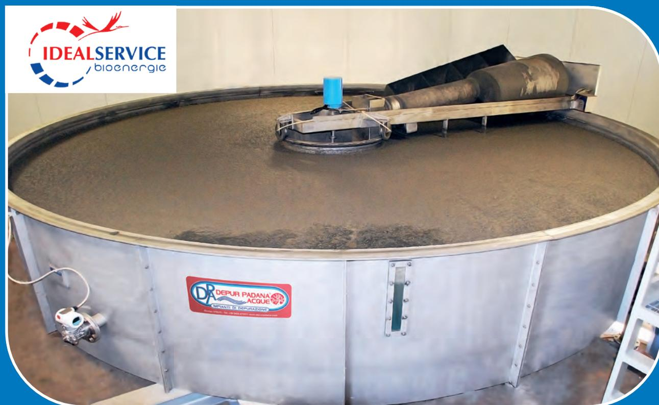
Flottatore ad aria disciolta pressurizzata, diametro 6 m, con potenzialità idraulica pari a 100 m<sup>3</sup>/h.
