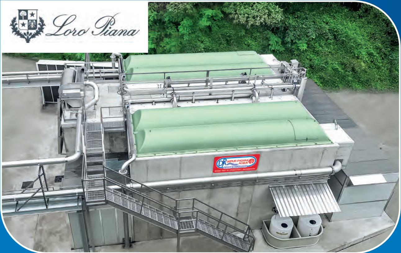
Nuovo impianto di trattamento acque reflue industriali, con applicazione di tecnologia MBR, finalizzato al riutilizzo delle acque in produzione. Potenzialità impianto fino a 2000 m<sup>3</sup>/g.
