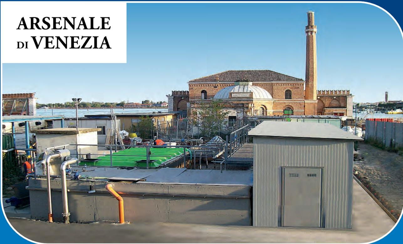
Impianto di depurazione biologico per reflui civili con tecnologia MBR. Realizzazione nell'ambito del piano attuativa per l'inserimento delle attività di realizzazione, gestione e manutenzione del "SISTEMA MO.SE." presso area nord Arsenale di Venezia. Portata 60 m<sup>3</sup>/g.
