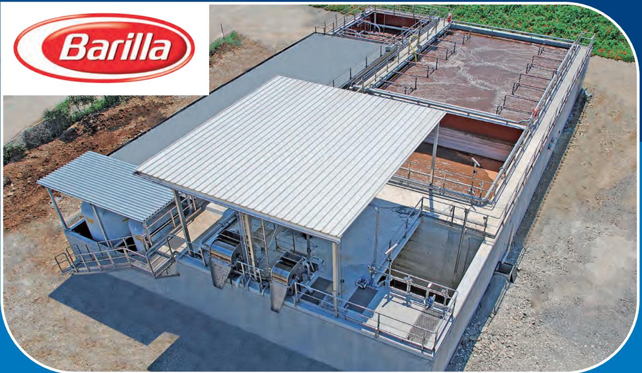
Impianto a tecnologie combinate: pretrattamento di sgrossatura mediante flottazione ad aria disciolta pressurizzata + trattamento biologico a fanghi attivi con applicazione innovativa tecnologica MBR. Potenzialità di trattamento: 30 m<sup>3</sup>/h x 24 ore/giorno.
