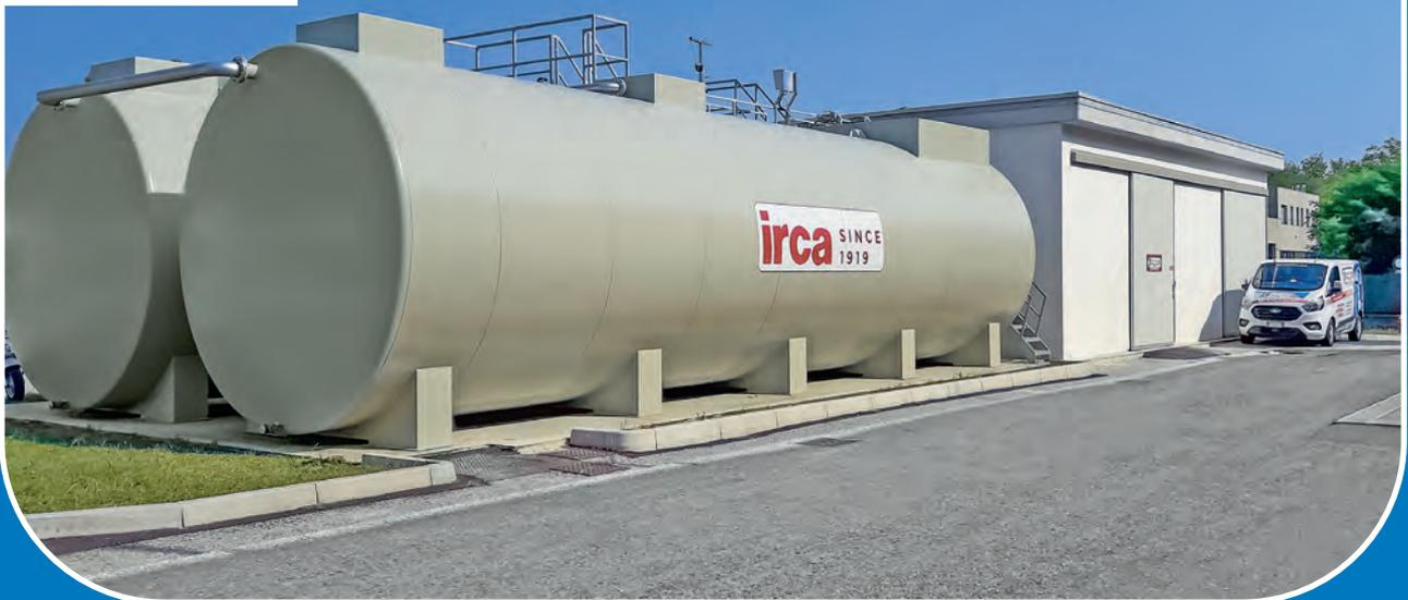
Impianto combinato con flottatore ad aria pressurizzata, doppio reattore biologico serie ECOBLOCK® a innovativa tecnologia MBR e gruppo disidratazione fanghi con Centrifuga, per il trattamento scarichi di industria dolciaria. Potenzialità 70 m<sup>3</sup>/g.
